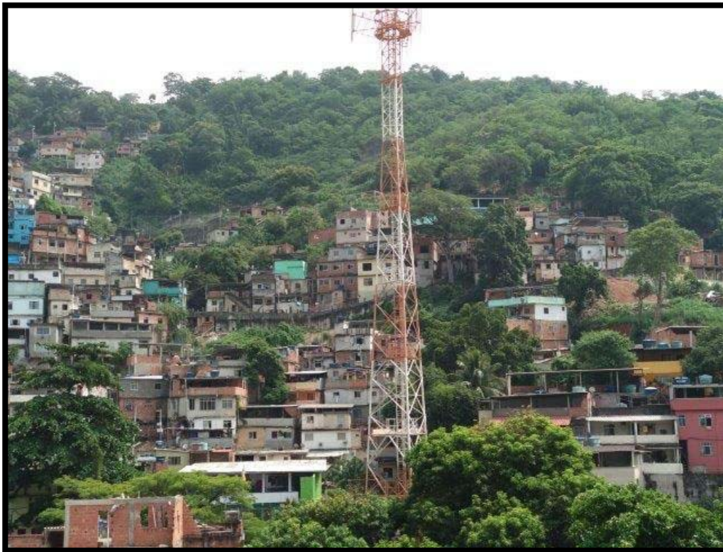
Figura 1: Foto de exemplo de Antena localizada vizinha a área de ocupação irregular
