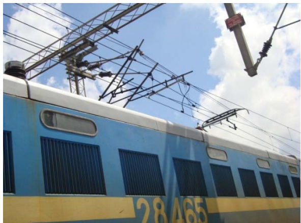
Fig. 4 : Panto entanglement at Turn out OHE.
