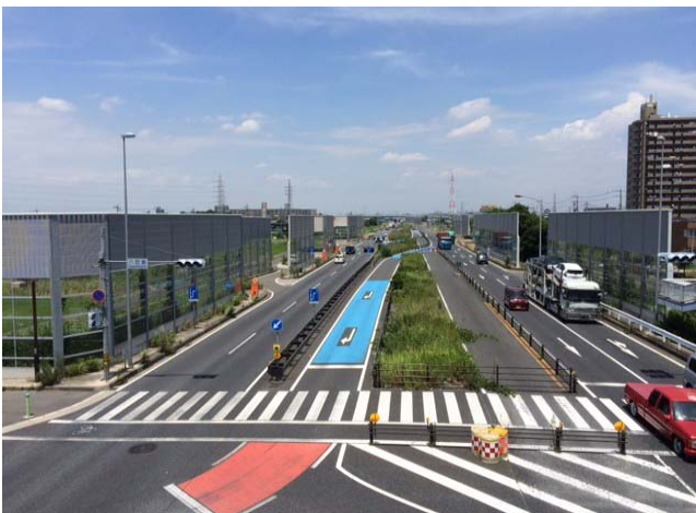
写真-1 工事箇所施工前状況
