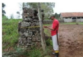
Figura 4.85. Perfil da Taipa de Pedra nº 45, P06, mostrando o encaixe das pedras sem rejunte com forma trapezoidal. Foto e Acervo: Scientia, 2018. Fonte: (HERBERTS A. L., 2021).
