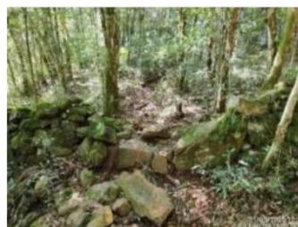
Figura 7.199. Estrutura colapsada do mangueiro de taipa de pedra. UTM 22J 500157/6957530. Foto e Acervo: Scientia, 2025.
