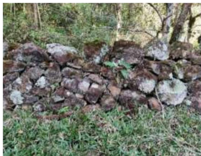
Figura 7.203. Detalhe para o encaixe de blocos de rocha sem material aglutinante.
