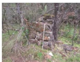
Figura 4.83. Perfil da Taipa de Pedra nº 30, P01, mostrando o encaixe das pedras sem rejunte com forma trapezoidal. Foto e Acervo: Scientia, 2018. Fonte: (HERBERTS A. L., 2021).
