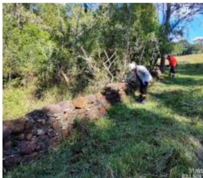
Figura 7.204. Detalhe para o encaixe blocos de rocha sem material aglutina UTM 22J 500152/6957551. Foto e Acervo: Scientia, 2024.
